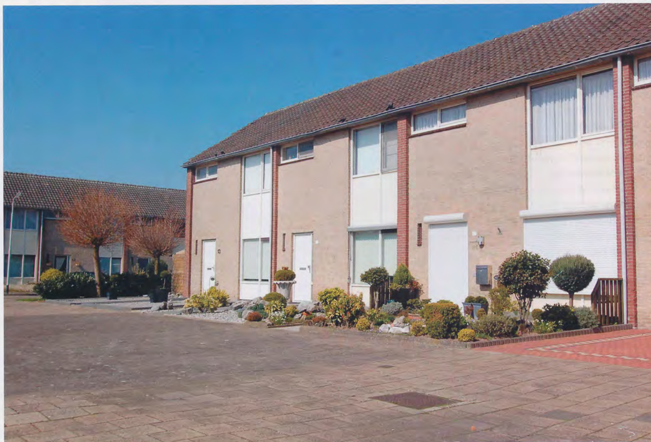
De SlimRenoveren schilrenovatie kan bij 80% van de naoorlogse grondgebonden rijtjeswoningen worden toegepast.
